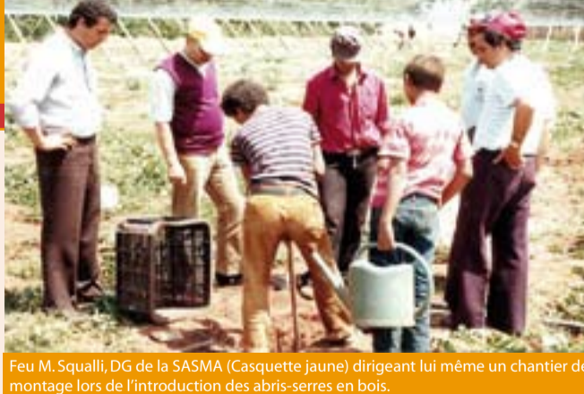
Fou M. Squalli, DG de la SASMA (Casquette jaune) dirigeant lui-même un chantier de montage local de l'introduction des abris-serres en bois.
